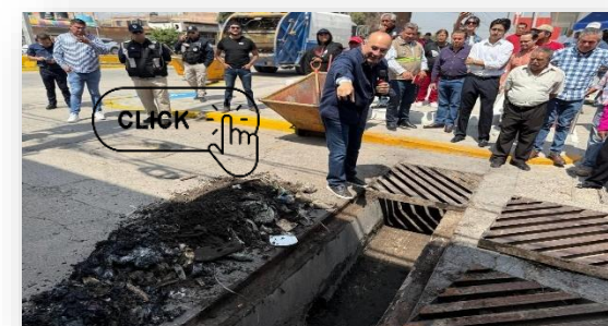
Imagen 64 Limpieza de alcantarillado
