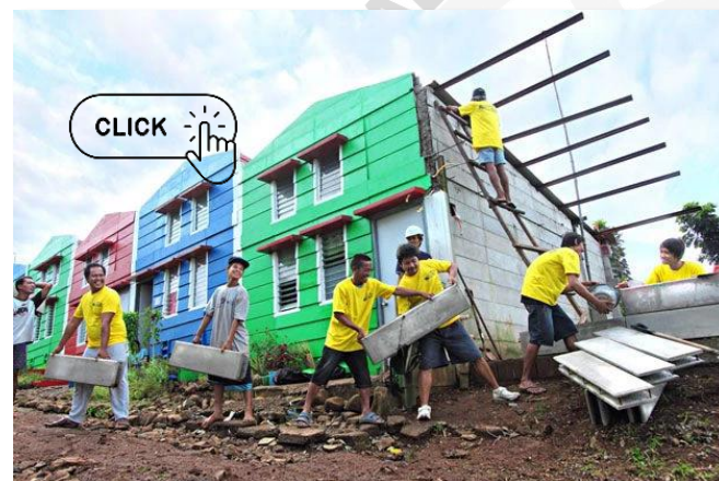
Imagen 69 Reconstrucción de viviendas
