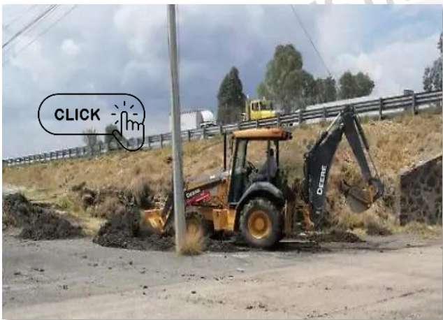
Imagen 87 Desazolve sobre zonas de inundación
