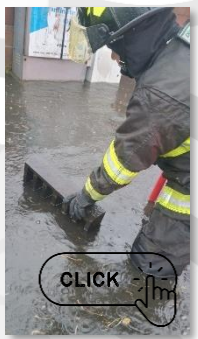
Imagen 6 Destapando coladeras para que fluyan los encharcamientos
