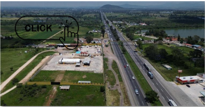
Imagen 35 Estación de carburación
