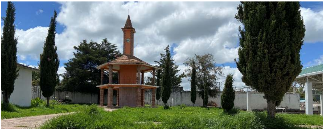
Fuente: Fotografías propias obtenidas en levantamiento de campo, 2022.
