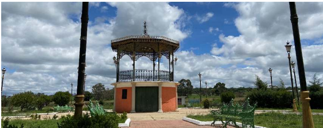
Fuente: Fotografías propias obtenidas en levantamiento de campo, 2022.
