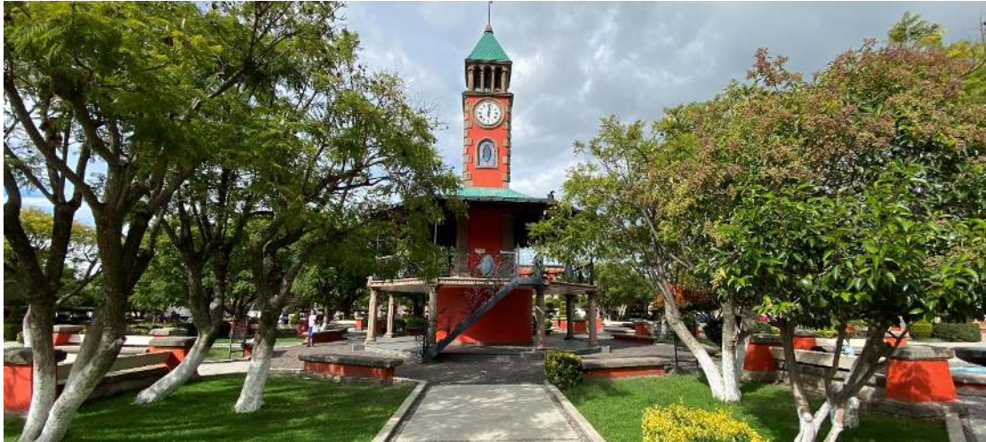
Fuente: Fotografías propias obtenidas en levantamiento de campo, 2022.
